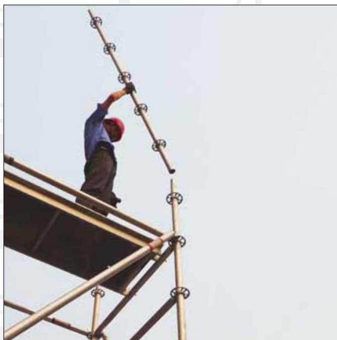
▲ 輕質鋁合金零部件有助於腳手架的快速搭建，節省勞動力。
