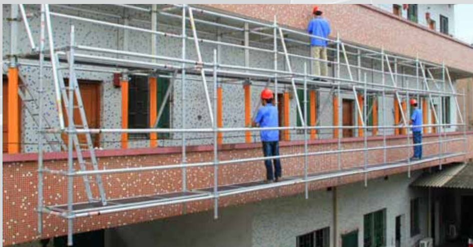
支柱配備外牆腳手架
