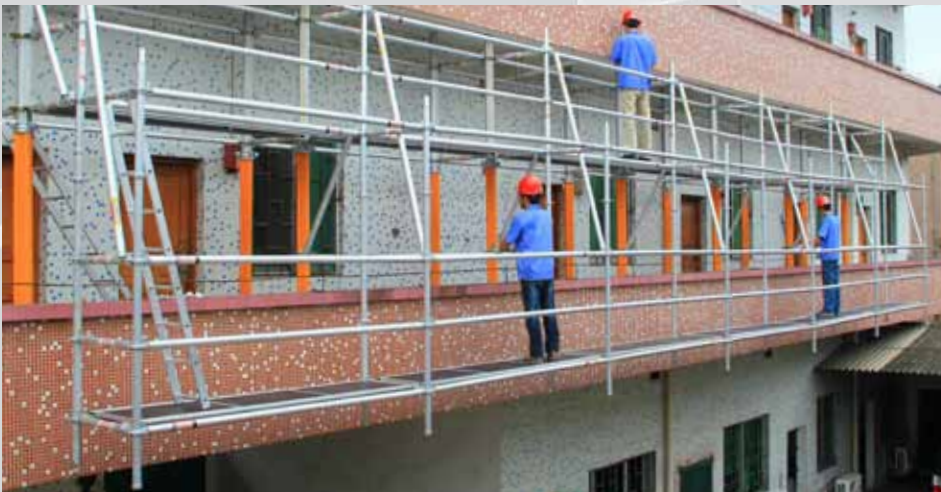
支柱配备外墙脚手架
